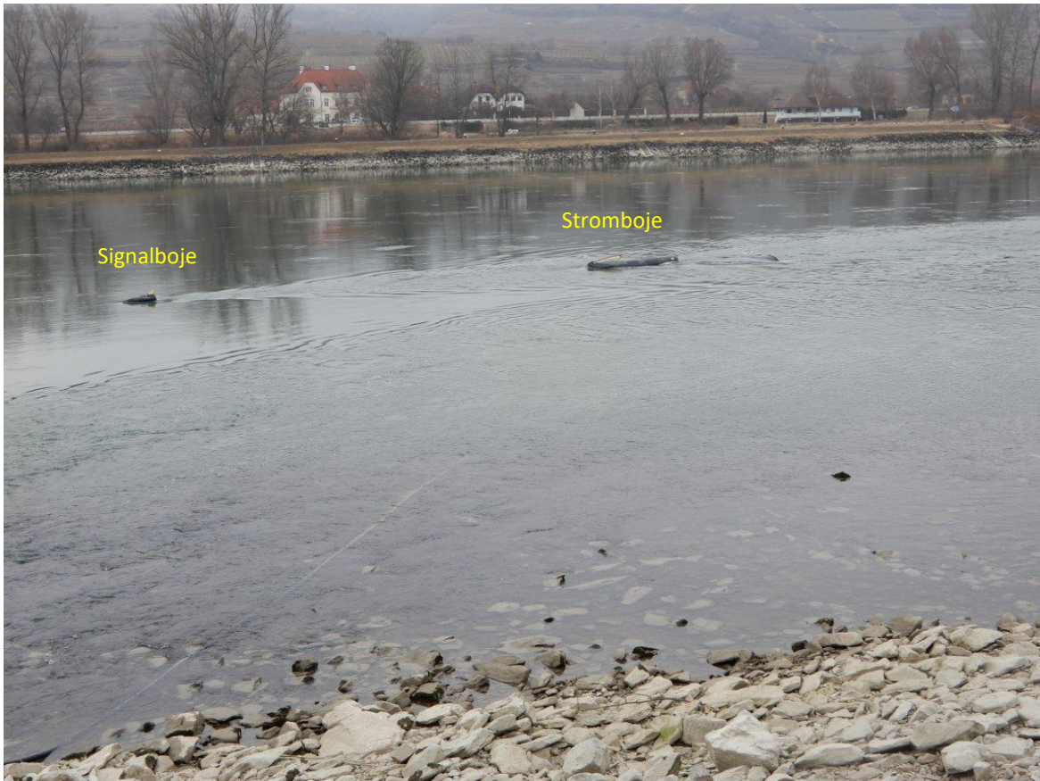
Abb. 1: Eingebaute Stromboje bei Niedrigwasserführung der Donau.
